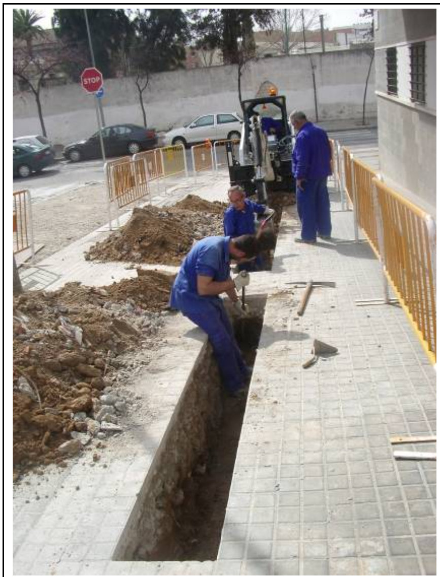
Fotografia 2. Rasa 1000. C/ Vilageliu i Gavaldà. Procés d'excavació
